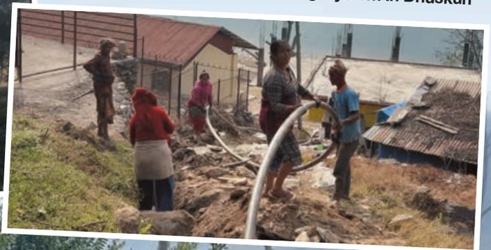
Verlegung der Rohre für das Wasserverteilungssystem in Dhuskun
